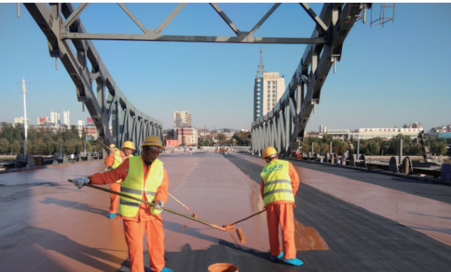
防水材料施工
