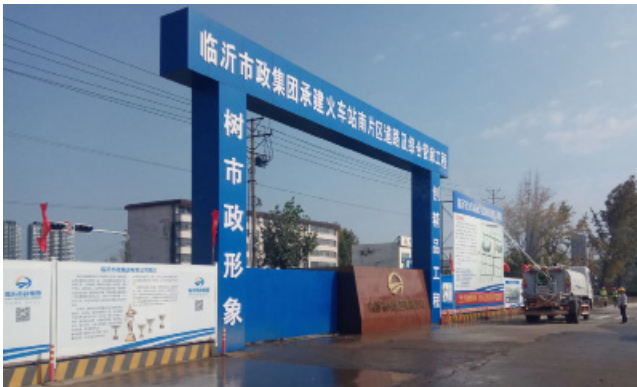
火车站片区文明施工措施到位
