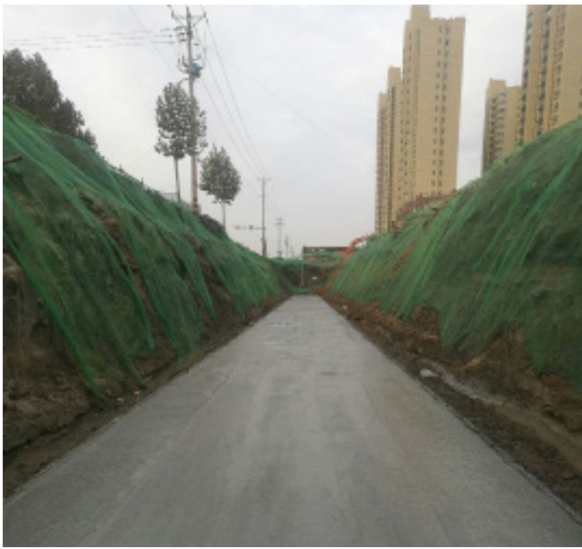
七公司火车站片区管廊垫层浇筑好
