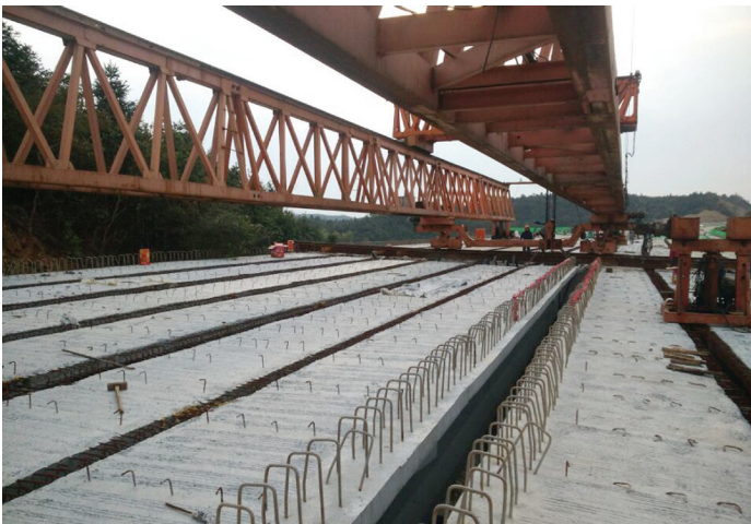
岳六标项目部收获了一枚沉甸甸的胜利果实。 项目开工以来，各部室负责人多次步行全段，开现场会研究分析，采用头脑风暴的方法制定了“不 不靠、主动出击，抓关键点、分节点控制施工”的施工策略，优化施工方案，细排节点、盯控现场，精心组织，确保施工有序推进。 七公司 邱军伟
